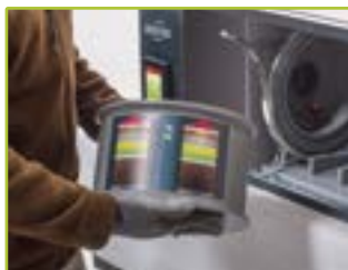
1 Deballer l'appareil, ouvrir la face avant du boîtier de ventilation et prendre le filtre
