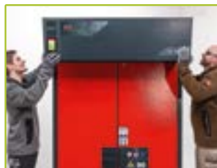
2 Placer le module de ventilation sur l'armoire et établir la connexion
